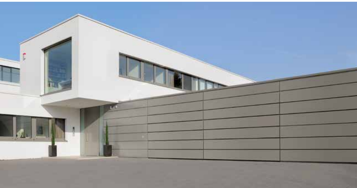
Beklædning fra bygherrens side med aluminium-sandwichplader
