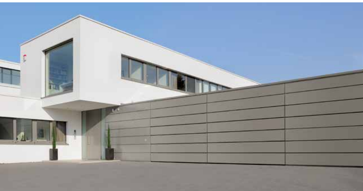
Beklædning fra bygherrens side med aluminium-sandwichplader
